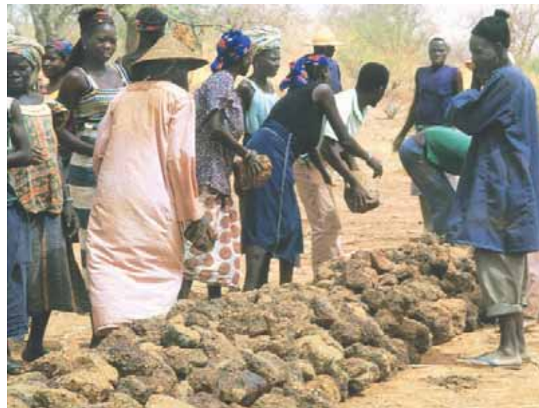
Burkina Faso: Die Steinwälle halten das Niederschlagwasser zurück und erhöhen so die Fruchtbarkeit des Bodens.
